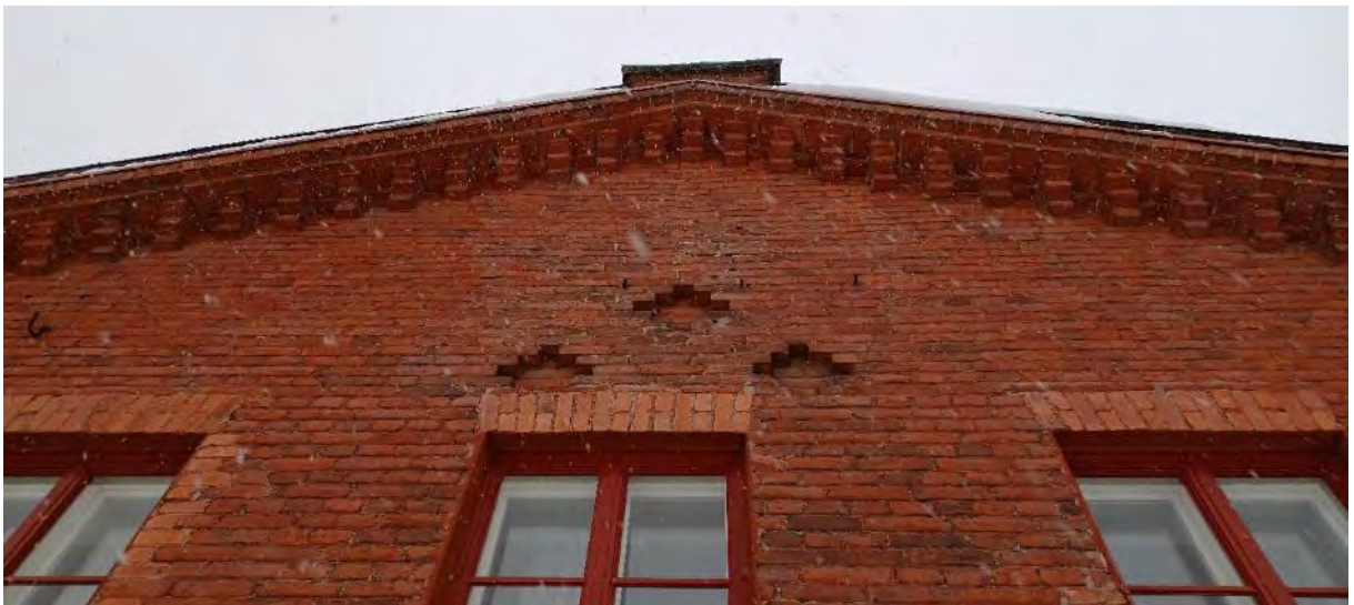
Kuva 39. Tiilikoristeluita länsipäädyssä. Tämä vanhin osa rakennuksesta – kaksi ensimmäistä pilttuuta sekä vesitorni – on kaikkein runsaimmin koristeltu.
