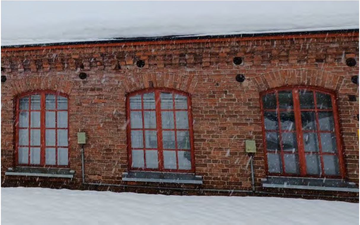
Kuva 58. Toimistopäädyn ikkunat etelän suuntaan.
