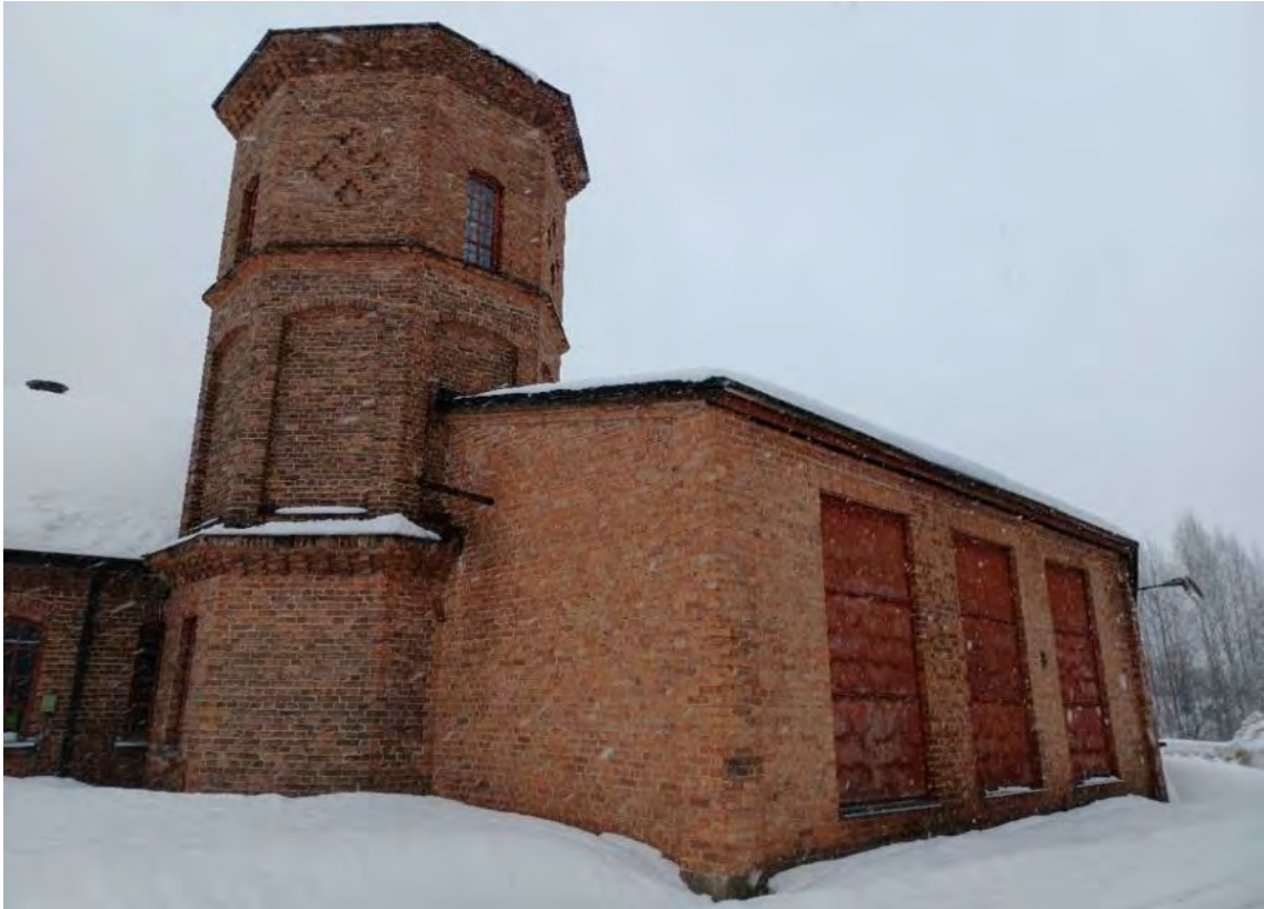
Kuva 42. 1880-luvun vesitorni ja 1940-luvun laajennusosa.
