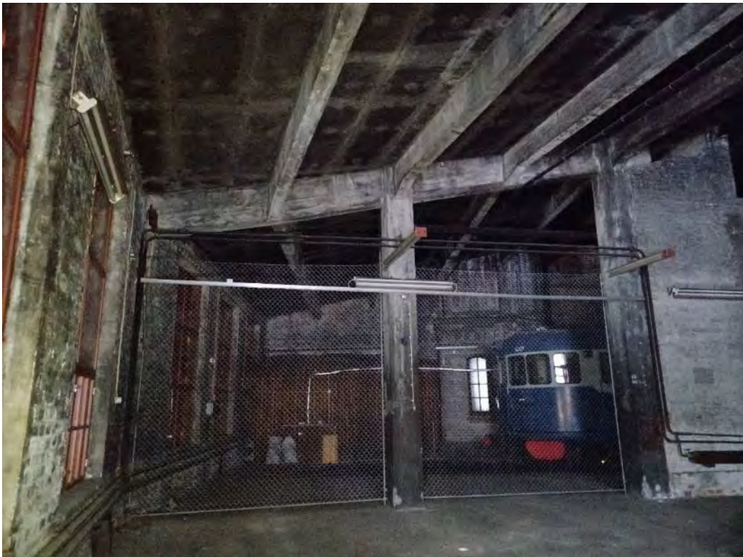
Kuva 92. Tilaa 7 ja 8 (takana) jakaa laajennusosan kohdalta verkkoaita. Kuvassa näkyvät hyvin laajennusosan betoniset tukipilarit sekä katon kannattajat ja levytys sekä betonilattia.
