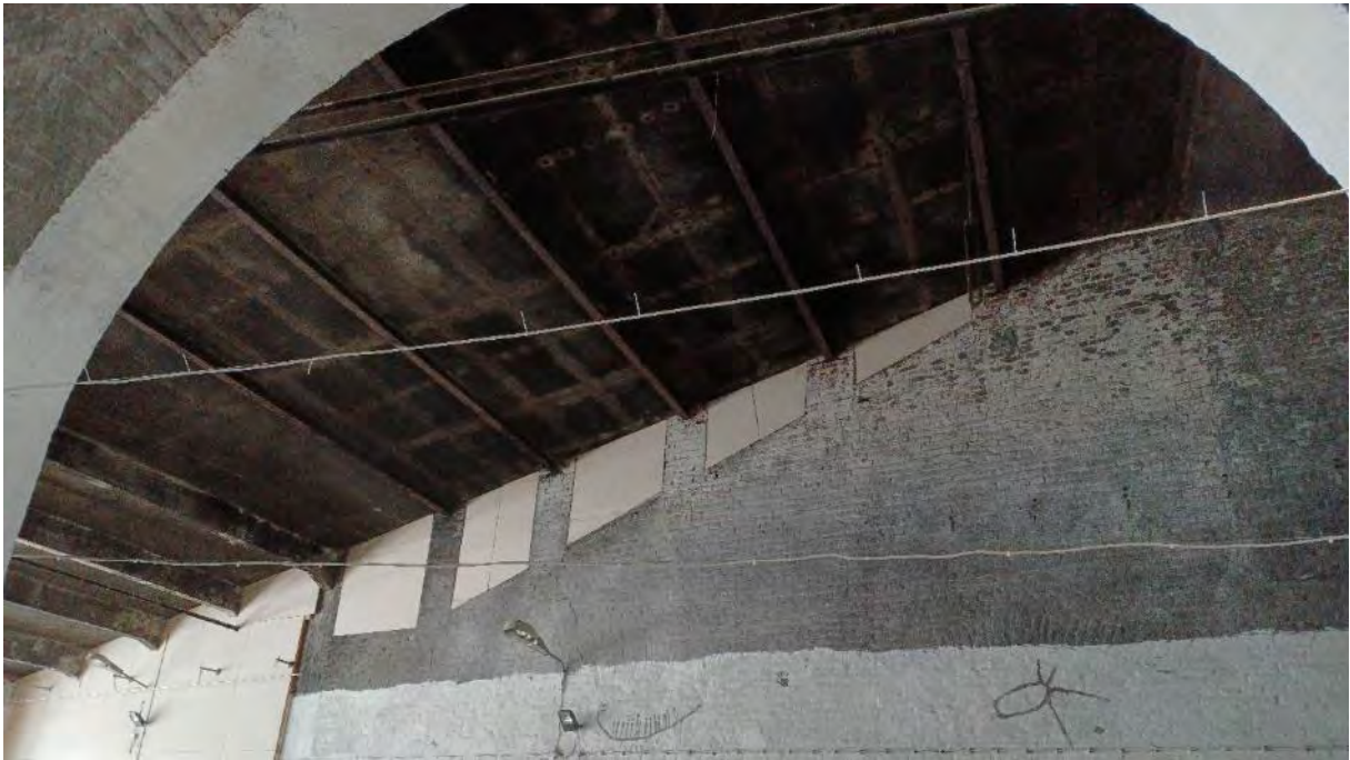
Kuva 103. Seinässä näkyy vanhoja, umpeen muurattuja ovi- ja ikkuna-aukkoja. Tämäkin seinä on ilmeisesti ollut ulkoseinänä muutaman vuoden ajan. Kattokulmaa on muutettu laajennusosan rakentamisen yhteydessä, mistä näkyy jäljet seinässä.
