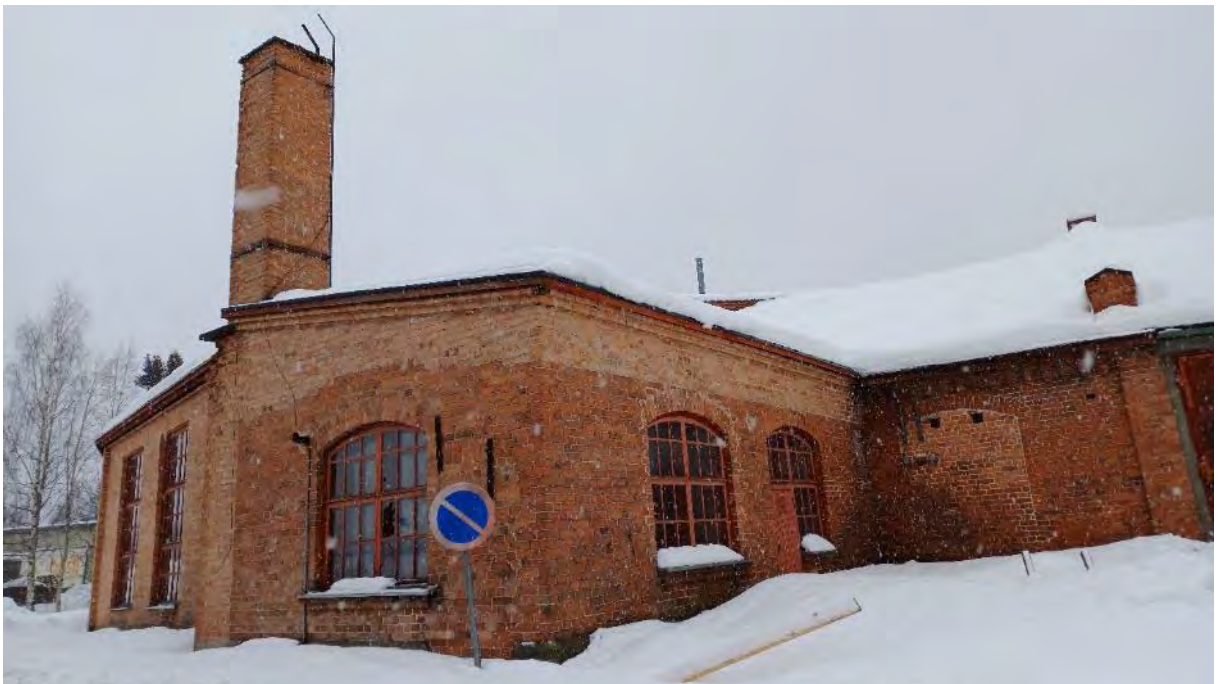
Kuva 45. Rakennuksen itäpuolta, 1908 rakennettua osaa. Keskellä entinen sauna/pannuhuone ja viimeksi rakennetut pilttuut oikealla. Vasemmalla näkyy 1940-luvun laajennus.
