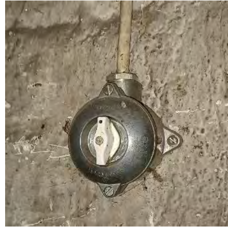
Kuva 96. Osa uusituista ikkunoista on tehty vanhan mallin mukaan. Vanha, kierrettävä valokatkaisija tilan 7 seinässä.
