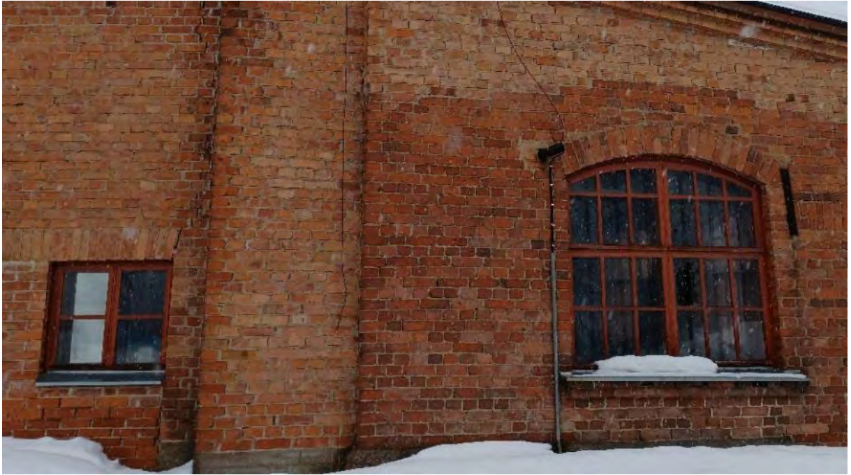
Kuva 60. Entisen polttoainevaraston ja pannuhuoneen ikkunat.
