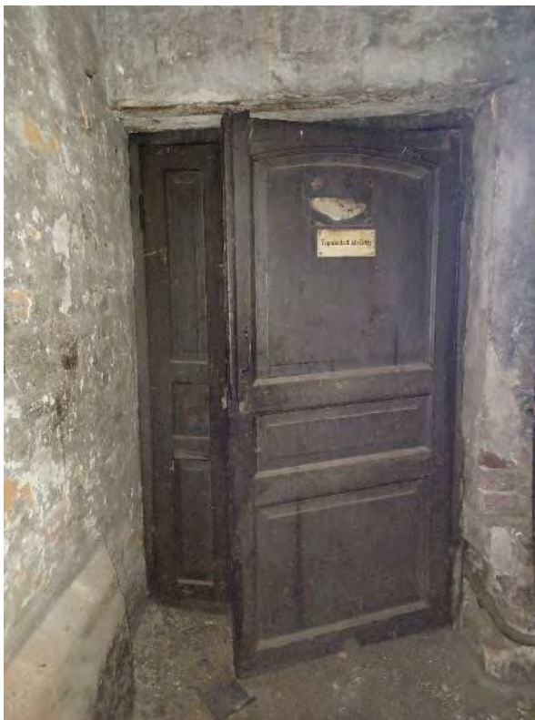
Kuva 84. Entisen vesitornin sisäänkäynti tila nro 9 puolelta.
