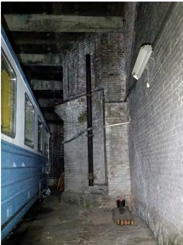
Kuva 90. Tilan 8 seinäpintaa, edessä vesitorni.
