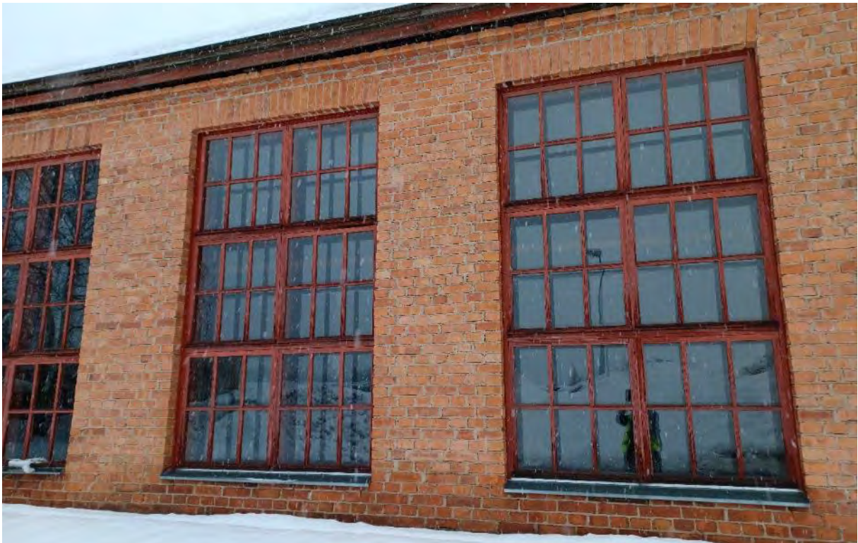
Kuva 59. Laajennusosan pieniruutuisia ikkunoita etelän suuntaan. Puitteet vaikuttavat alkuperäisiltä.
