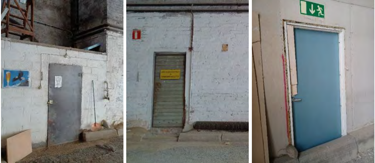
Kuva 98. Tilan ovia: Vasemmalla öljykattilahuoneen (tila 2) metalliovi. Keskellä todennäköisesti alkuperäinen, vaakaneloitu ovi öljykattilahuoneeseen. Oikeanpuolimmaisessa kuvassa väliovi, joka johtaa viereiseen pilttuuseen (tila 6).
