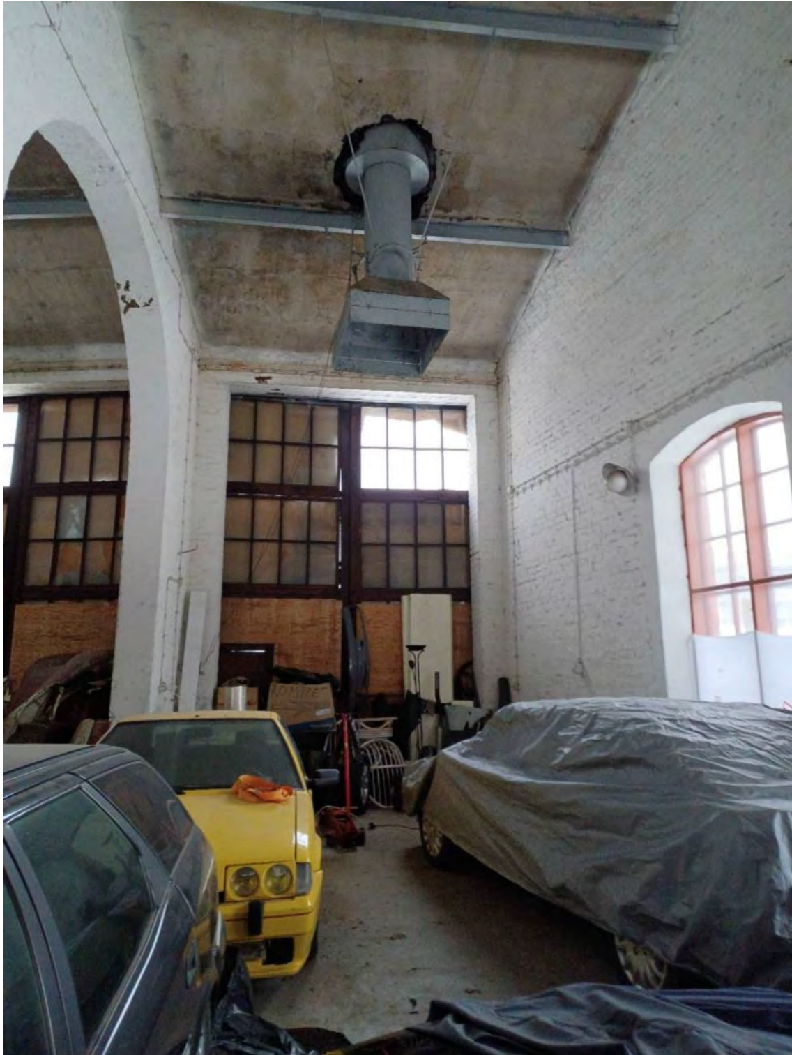
Kuva 105. Tilassa on betonilattia ja tiiliseinät. Puisten, alkuperäisen mallin mukaisten tallinovien (1 ja 2) suuret, moniruutuiset ikkunat on peitetty vanerilla ilkeivällä vuoksi. Ikkunoiden sisäpuitteet vaihdettu 1-ruutuisiksi. Pyöreät valaisimet todennäköisesti alkuperäiset, ja toimivat edelleen.
