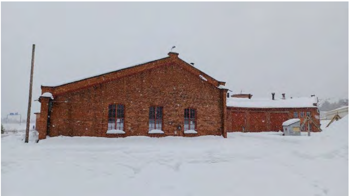
Kuva 36. Kuvan suunta suunnilleen pohjoisesta etelään. Etualalla olevassa rakennuksen pohjoispäädyssä on autotallitoimintaa.
