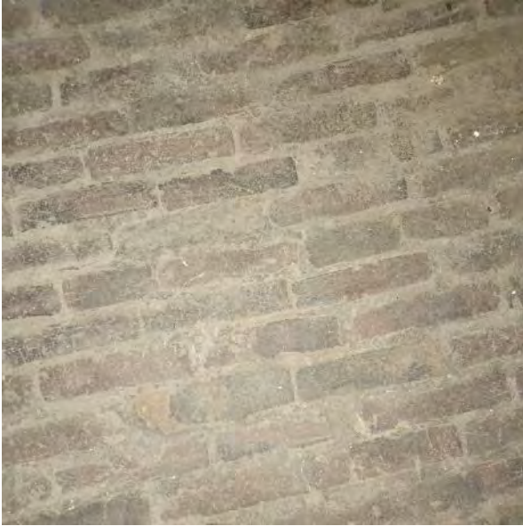
Kuva 75. Lattia on ladottu punatiillistä.
