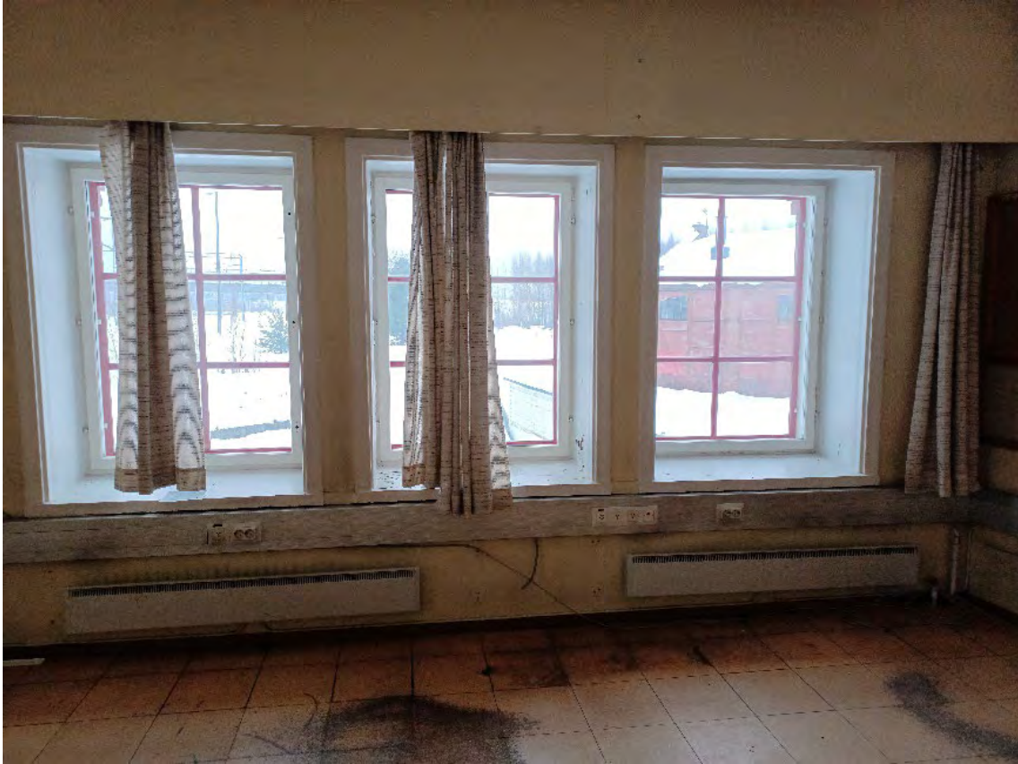
Kuva 71. Isompi toimistohuone, jonka ikkunat ovat sisäpihalle päin.
