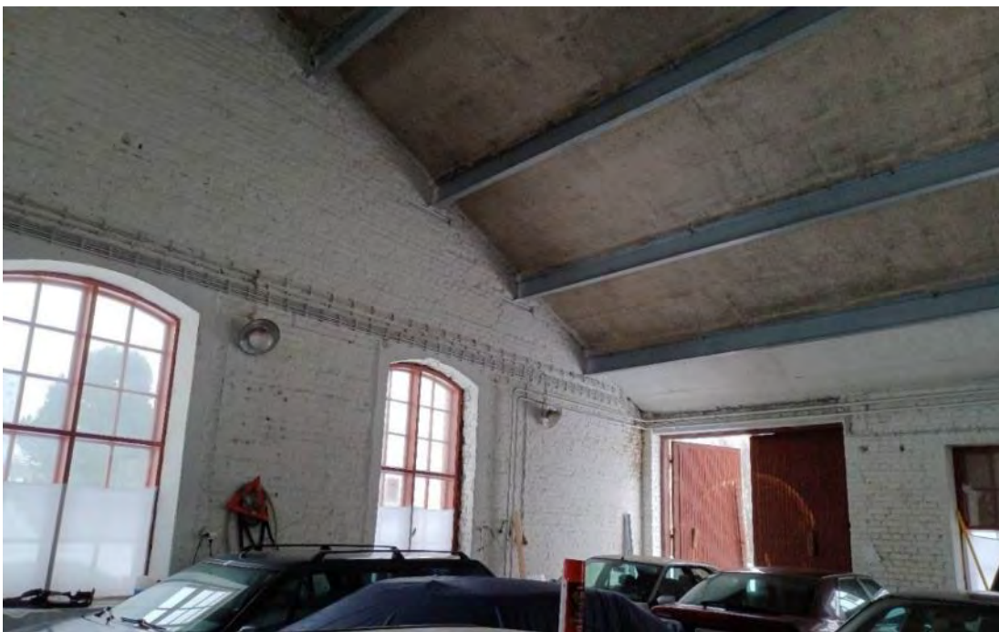
Kuva 107. Näkymä rakennuksen pohjoispäädystä kohti ovea 11.
