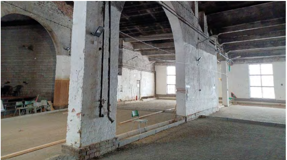
Kuva 97. Pilttuiden lattiapinnat on päällystetty hiekalla.
