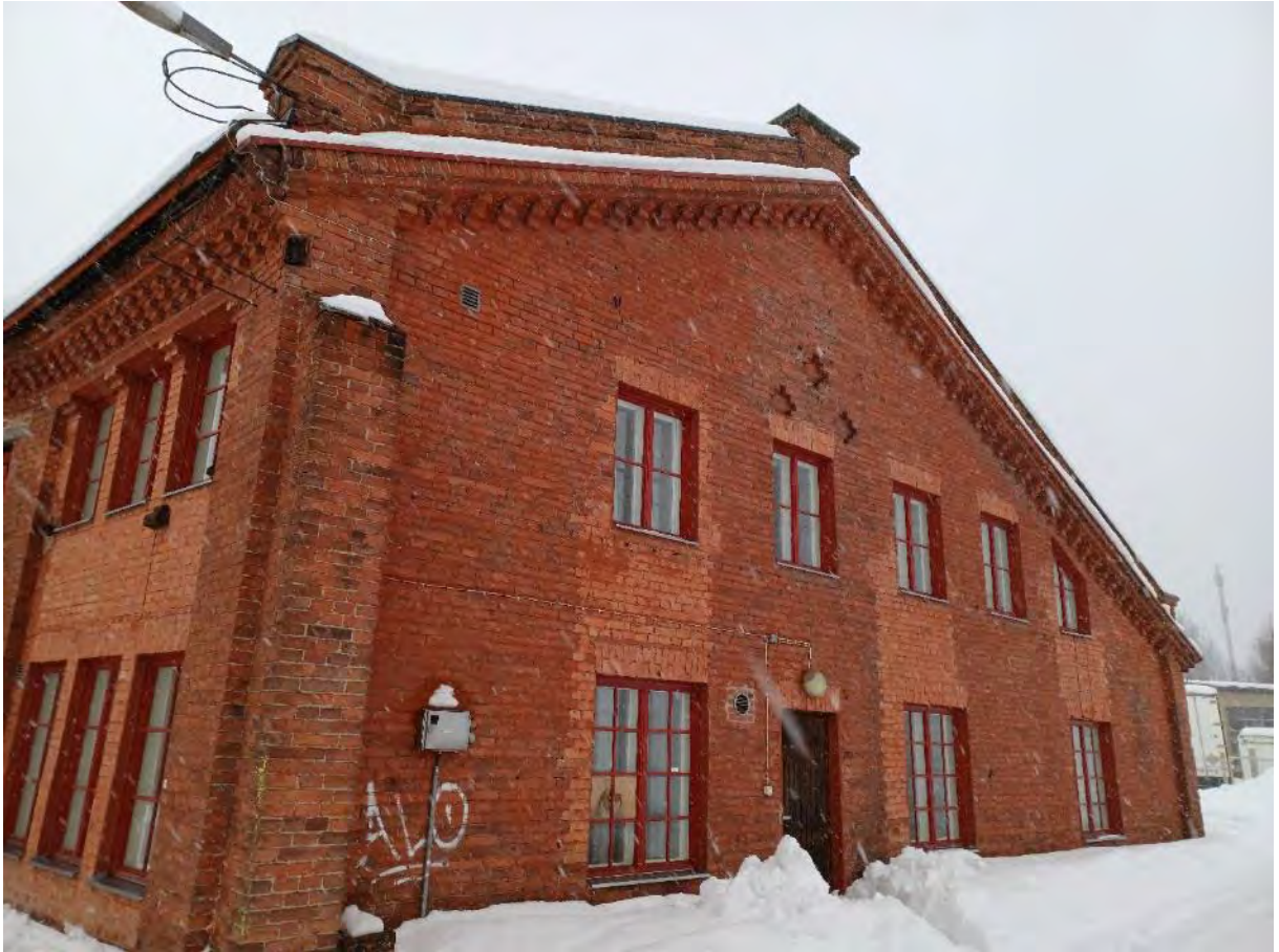
Kuva 40. Rakennuksen länsipääty ja vanhin osa, jossa on tehty eniten muutoksia. Vanhoja aukoksia on muurattu umpeen, päätyyn on rakennettu ovi ja ikkunoita on pienennetty.
