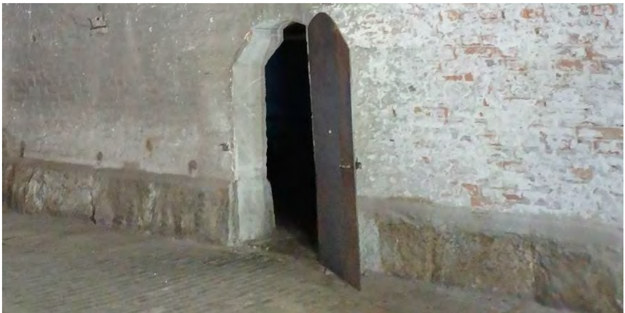
Kuva 32. Kuvassa näkyvä nykyinen väliseinä on alun perin ollut ulkoseinä. Sokkeli on luonnonkiveä, samoin perustukset. Lattia on ladottu tiilistä.
