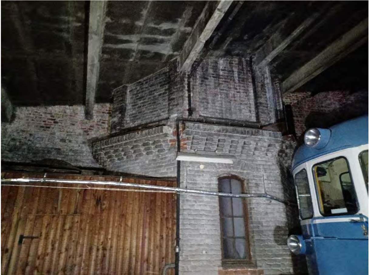
Kuva 87. Vesitorni on jäänyt osittain viereisen pilttuun (tila 8) sisälle.
