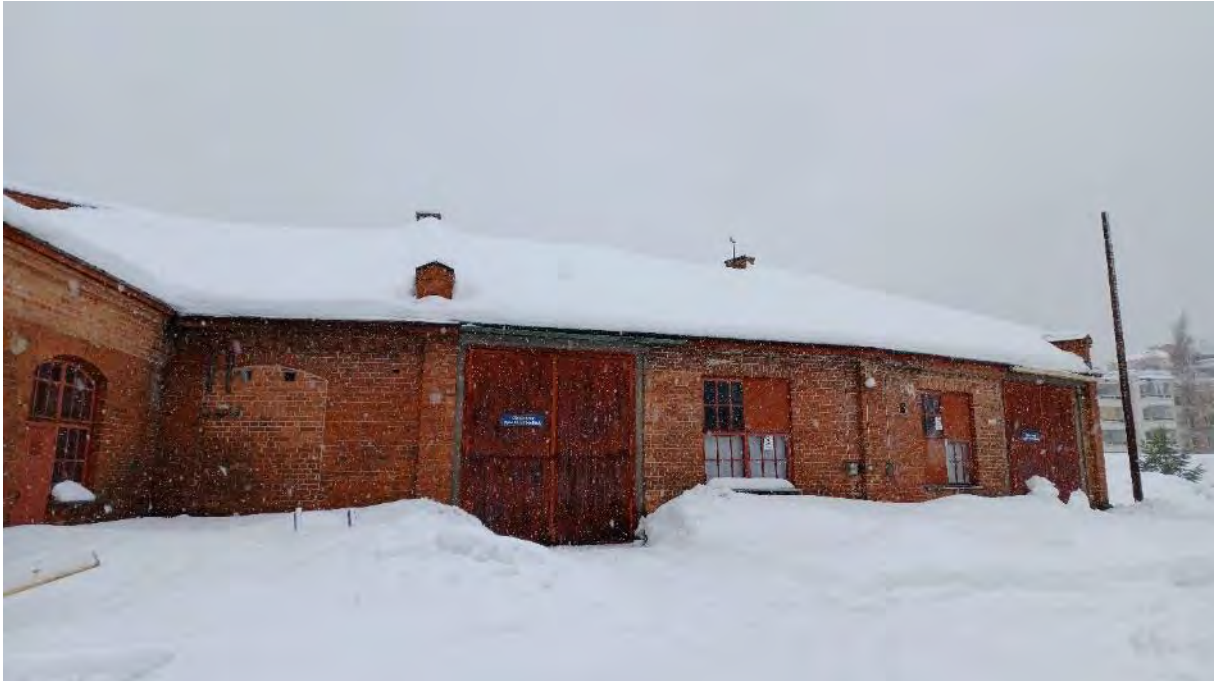
Kuva 46. Oikealla arviolta 1908–1913 rakennetut pilttuut (tila 1) ja vasemmalla osia vuodelta 1908. Umpeen muuratun ikkunan takana on ollut öljysäiliö.
