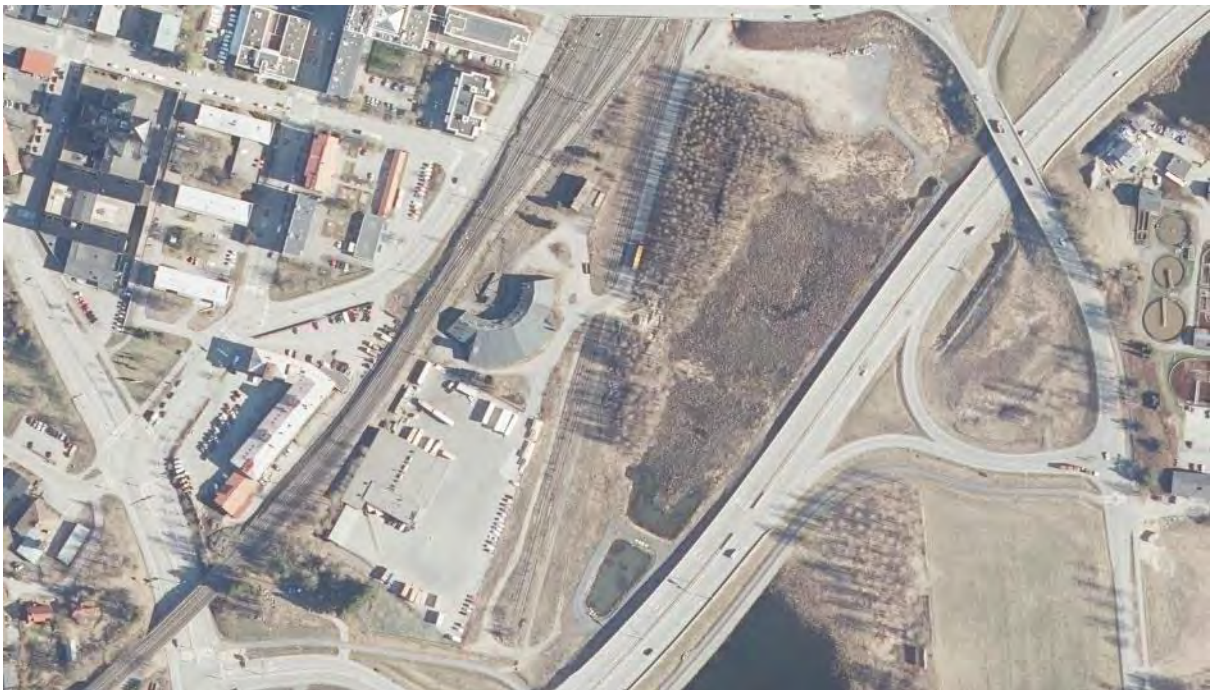
Kuva 21. Veturitalli ympäristöineen ilmakuvassa. Lähde: Maanmittauslaitos. Paikkatietoikkuna.
