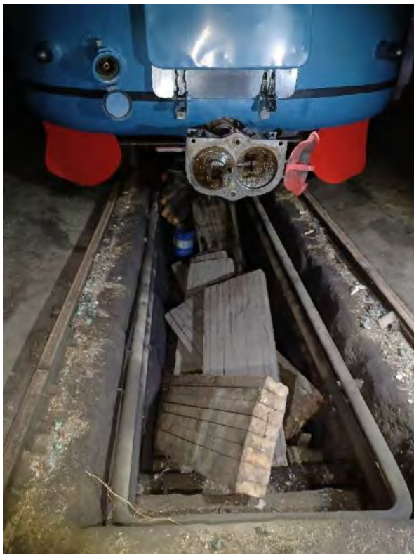
Kuva 88. Lättähatun alla oleva huoltokanaali tilassa nro 8.
