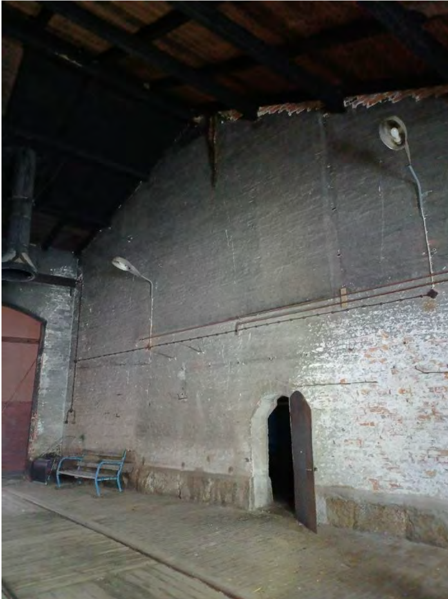
Kuva 77. Veturitalli oli aluksi kaksipilttuinen, ja tämä seinä on ollut ensimmäisen rakennusvaiheen (1889) ulkoseinä.
